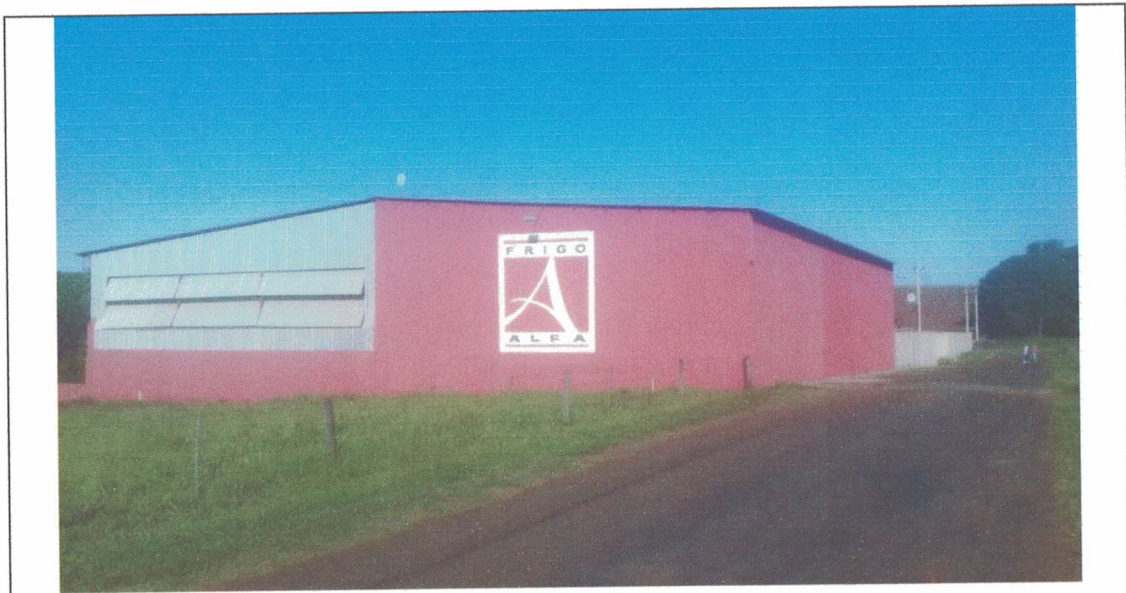
Foto 1. Vista da chegada ao frigorífico pela via particular asfaltada.
