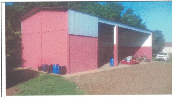
Foto 04. Galpão oficina com 98,48 m 2 .
